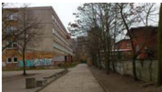
Abbildung 55 | Neubau der Grundschule am Planetarium
