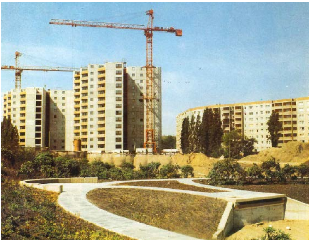
Abbildung 3 | Errichtung des Thälmannparks (Bauakademie der DDR, 1986, S.52)
