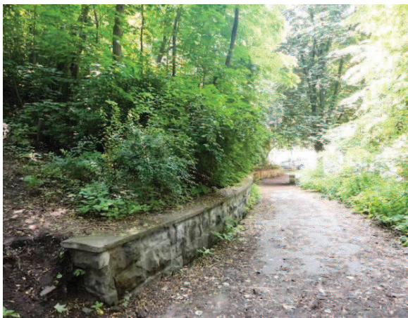
Abbildung 28 | Weg mit Natursteinmauer (STATTBAU,2013)
