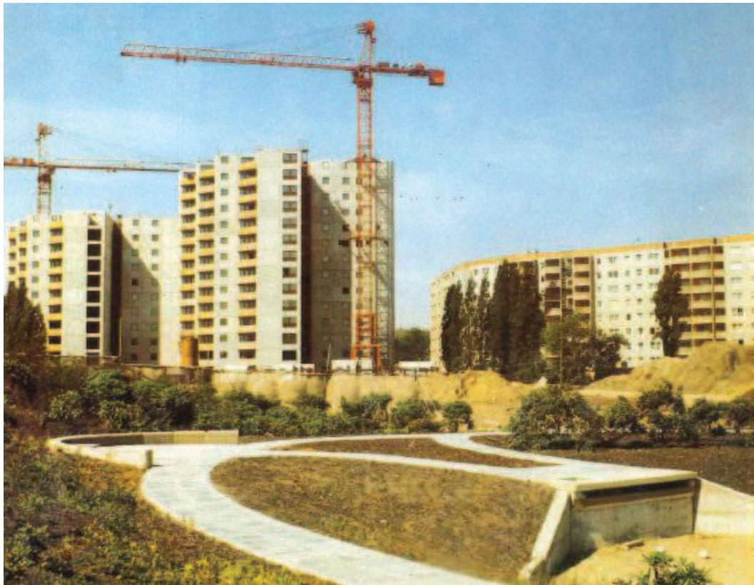
Abbildung 3 | Errichtung des Thälmannparks (Bauakademie der DDR, 1986, S.52)
