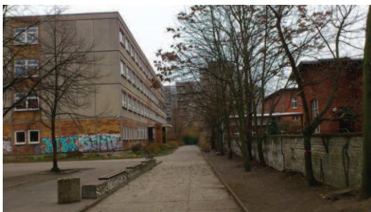
Abbildung 56 | Neubau der Grundschule am Planetarium
